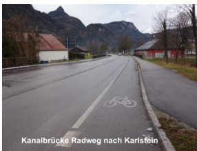
Kanalbrücke Radweg nach Karlstain
